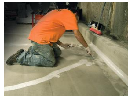
Applicateur Stonhard appliquant un traitement des fissures avant d'appliquer le produit Stondeck
